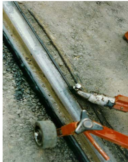
Abbildung 2: Detail Düse: Die vorgewärmte Bitumenmasse wird direkt mit dem TOKOMATEN an den Schienenkopf appliziert.
