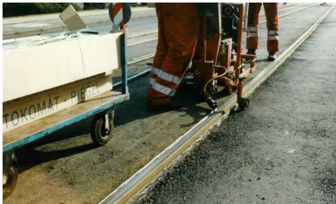
Abbildung 2: Detail Düse: Die vorgewärmte Bitumenmasse wird direkt mit dem TOKOMATEN an den Schienenkopf appliziert.
