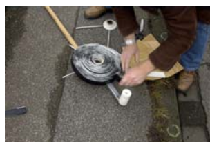
Rissband SK einlegen
