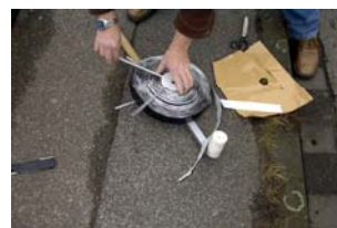
GK- Kupplung schließen
