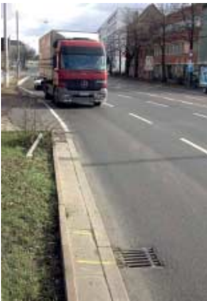
1 Straßenablauf in der Fahrspur einer viel befahrenen Straße
