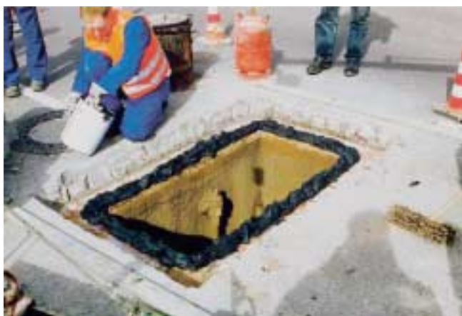
3 Verarbeitung des Densolastic EM auf der Testbaustelle in Köln
