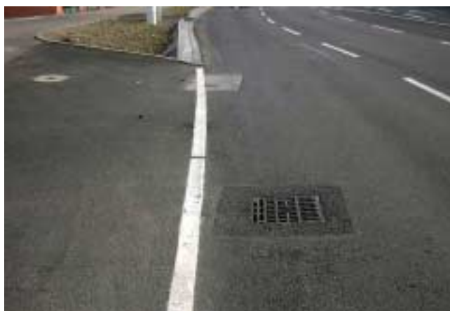
4 Einlaufschacht in der Pragstraße in Stuttgart
