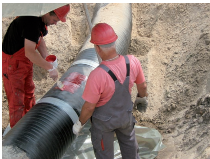
Bild 2: Auftragen des Epoxid Primers Fig. 2: Application of Epoxy primer
