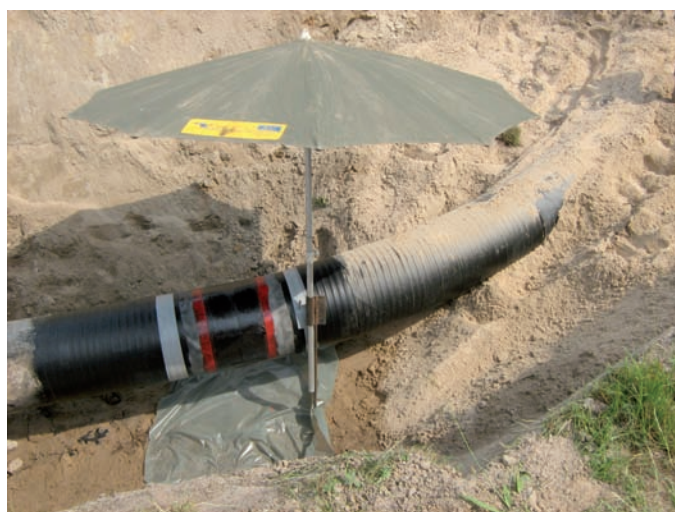
Bild 5: Sanierter Rohrabschnitt mit Black Diamond-System vor Aufbringung des Korrosionsschutzsystems
