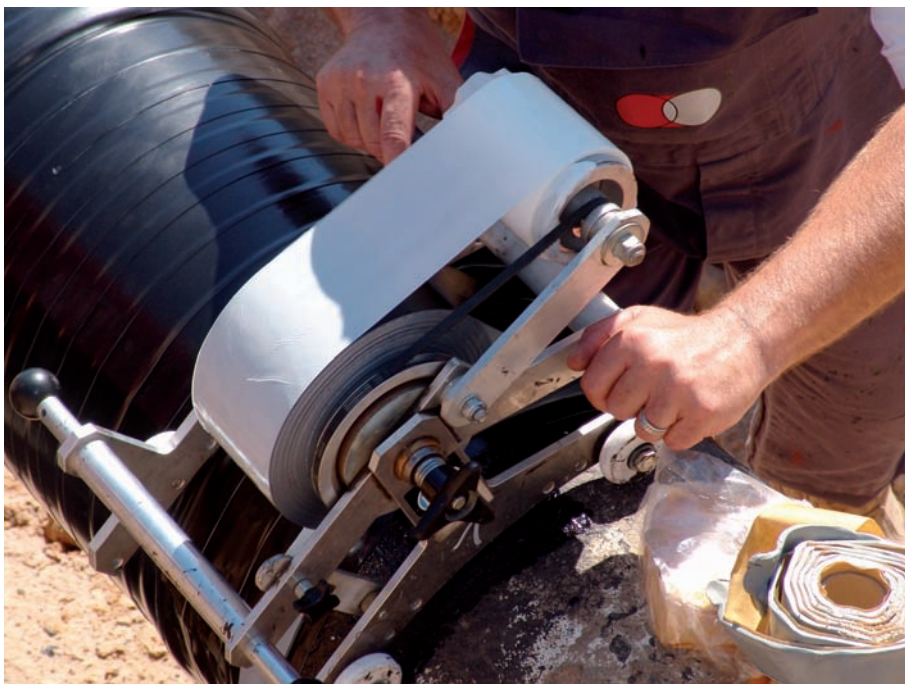
Bild 6: Elektrische Isolation und Korrosionsschutz durch Aufbringen von vier Lagen DENSOLEN-Band AS 40 Plus
