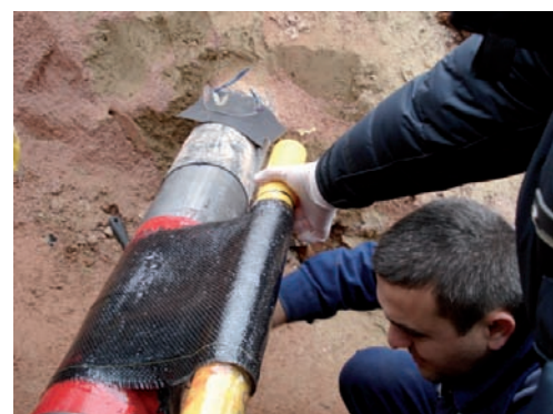
Bild 1: Sanierung einer Gasleitung in der Türkei mit Black Diamond System
