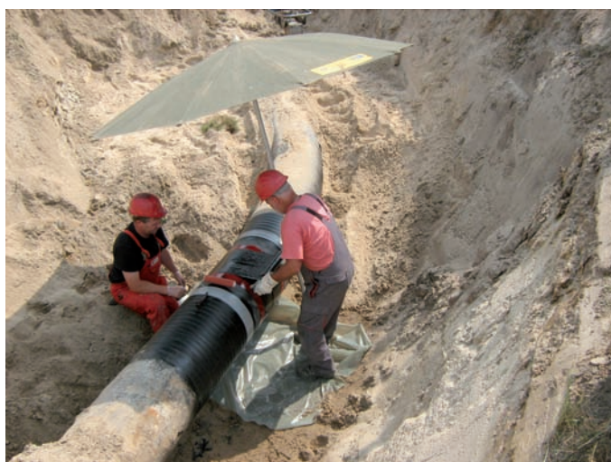
Bild 4: Aufbringen der getränkten Carbonmatten in mehreren Lagen
