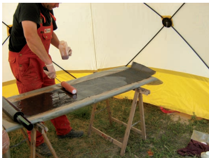
Bild 3: Tränken der Carbonmatte mit Epoxidharz Fig. 3: Wet out of carbon mesh with 2-component Epoxy wet-out
