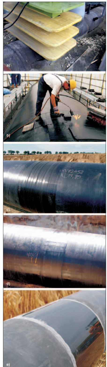
Bild 2: Normungs- und regelwerkskonformer Einsatz von Nachumhüllungsmaterialien: a) Petrolatumband, b) Bitumenband, c) Kunststoffbandsystem, d) Schrumpfmanschette, e) Polyurethan-Schweißnahtbeschichtung
