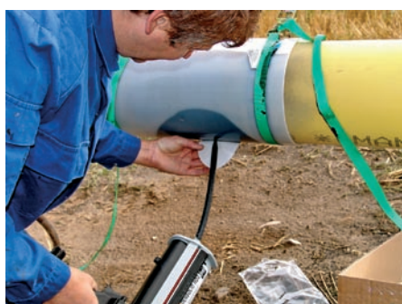
Bild 4: Befüllen der Schalung Fig. 4: Filling of the casing sheet
