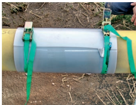
Bild 3: Fertig angebrachte Schalung Fig. 3: Assembled casing sheet
