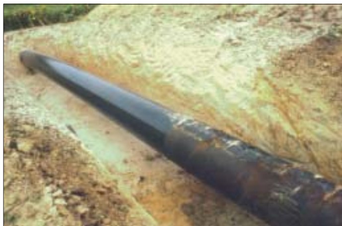
Bild 2: Anwendungsgebiet Umhüllungssanierung bei Rohrleitungen
