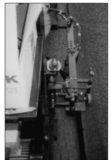
Maschinelles Verlegen eines selbstklebenden Bitumenfugenbandes mit dem Win Fox
