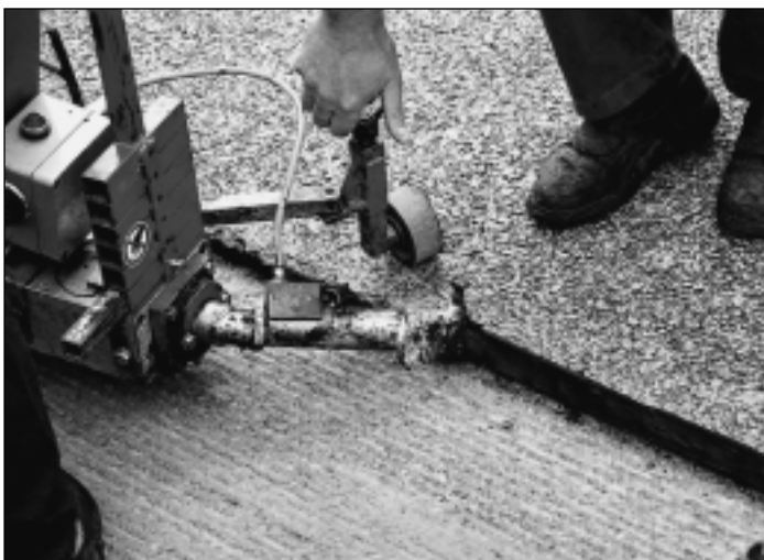
Anbringen des Bitumenfugenbandes mit dem Tokomat. Detailaufnahme der verstellbaren Düse. Rechts im Bild das bereits angebrachte Profil
