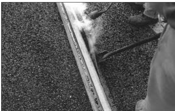
Abbildung 3: Verlegung des TOK-Band T an einer Schiene
