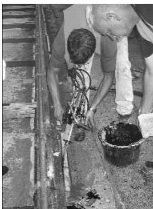
Abbildung 5: Maschinelle Verarbeitung des Densolastic SU-Mischkopf des Spezialgerätes
