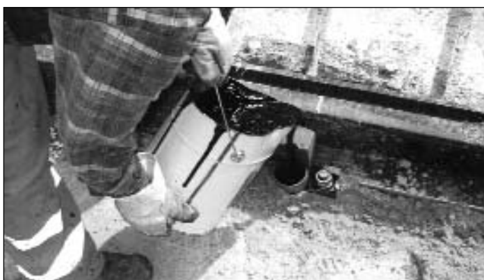
Abbildung 4: Manuelles Untergießen aus dem Gebinde
