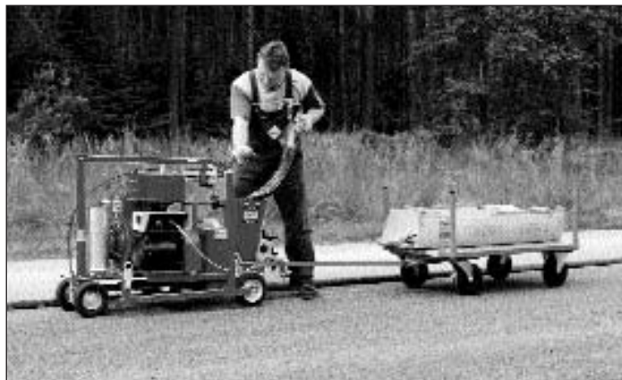
Abbildung 3: Maschinelle Verarbeitung eines Bitumenfugenbandes mit dem TOKomat
