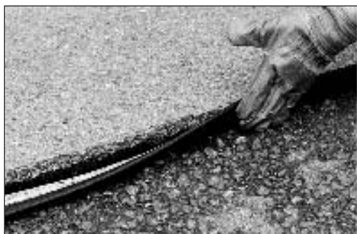
Abbildung 2: Verlegung des selbstklebenden TOK-Band SK. Deutlich erkennbar die weiße Klebeschicht
