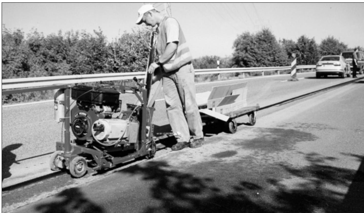
Einbau des Fugenbandes mit dem Tokomat auf der A 46 bei Neuss
