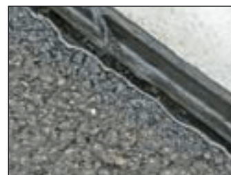
Abb. 4: Da das Material in dem Gerät erwärmt wird, kann es sich optimal an raue Flanken und andere Fehlstellen anpassen
