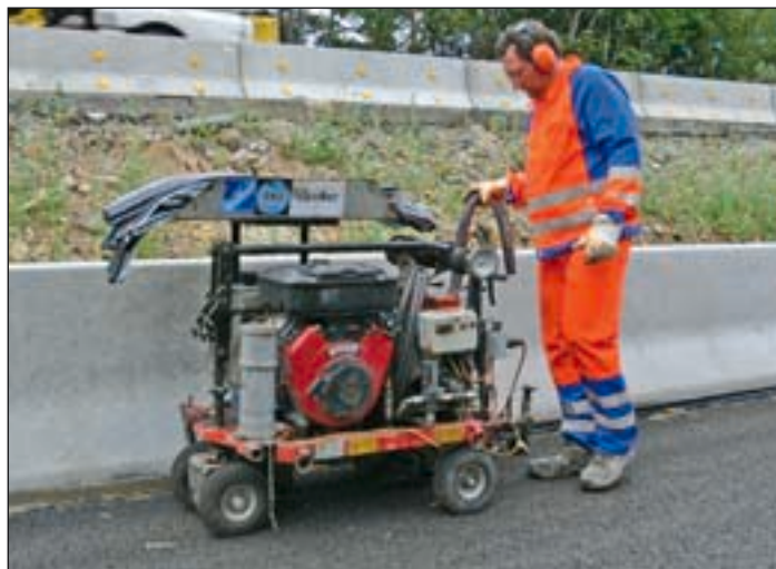
Abb. 2: Bei dem TOKOMAT-Verfahren wird das Bitumenfugenband maschinell eingebaut
