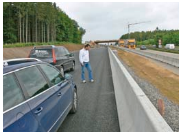
Abb. 1: Eine Betongleitwand trennt die Richtungsfahrbahnen auf der A 8 zwischen Stuttgart und Karlsruhe. Fotos: DENSO
