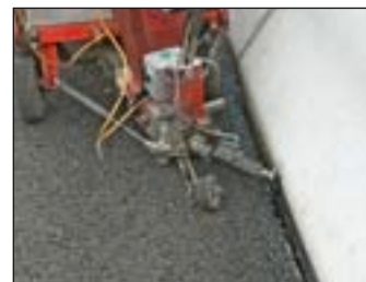
Abb. 3: Das Fugenband wird vor Ort in dem Gerät hergestellt und direkt an die Betonwand angebracht
